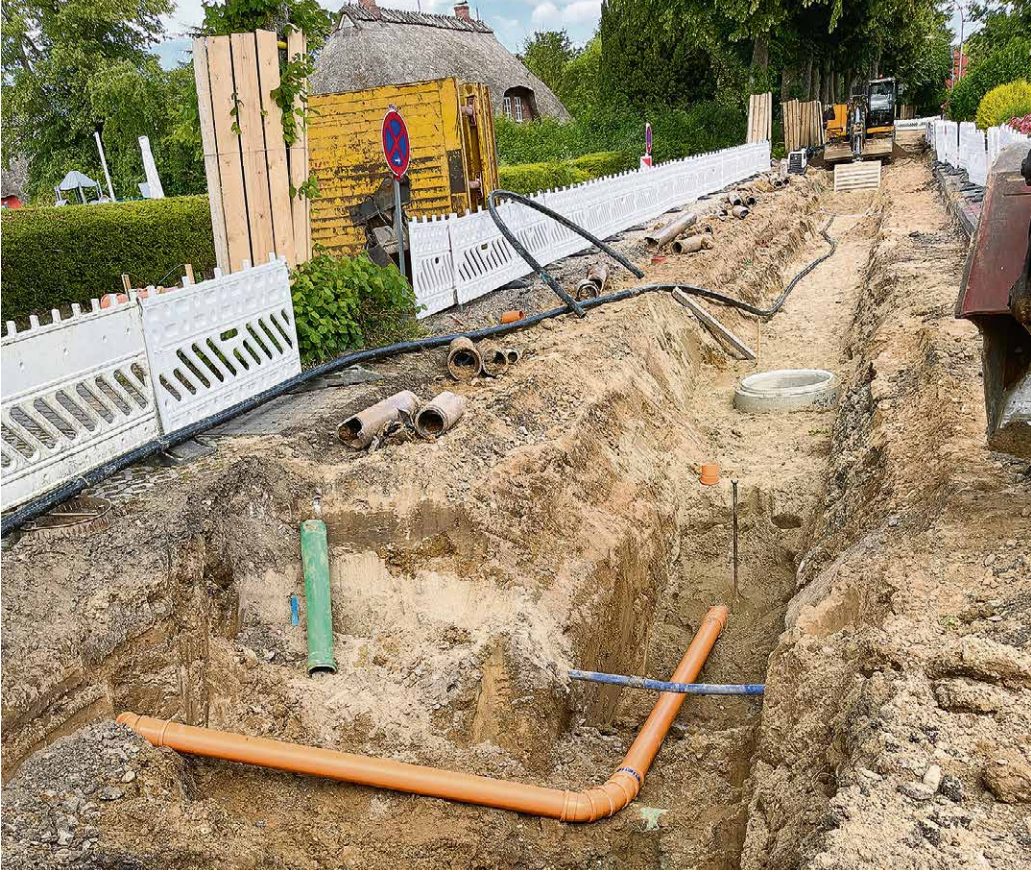
Abwasserleitungen, Schächte und Hausanschlüsse erneuerte der WV Nordangeln in Husby. Die Straßenbäume wurden besonders geschützt.
