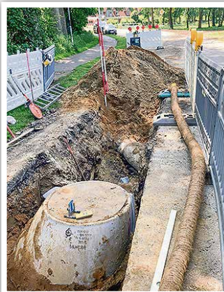
In Großenwiehe erneuerte der WV Nord 400 Meter Regenwasserkanal.
