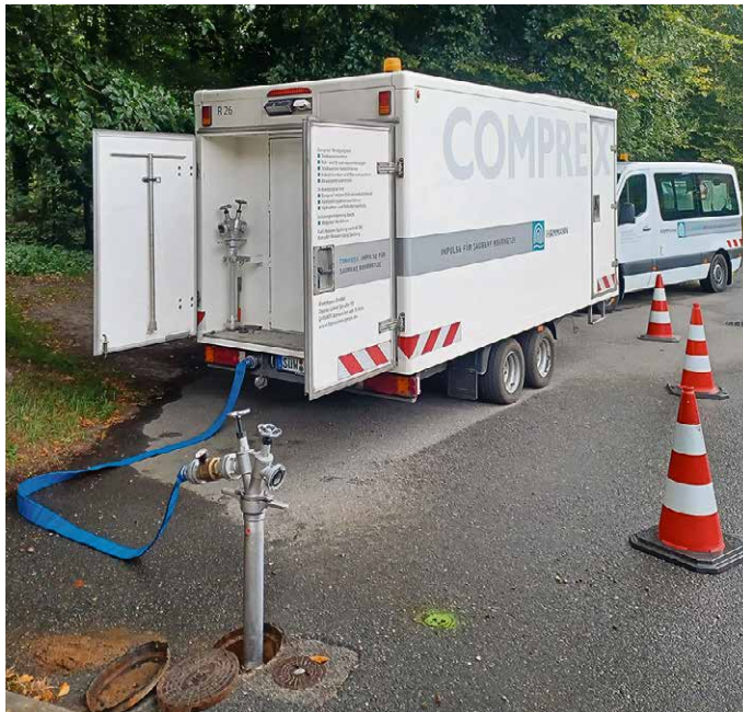
Der Kompressor zur Erzeugung des höheren Luftdruckes steckt in dem kompakten Anhänger.
