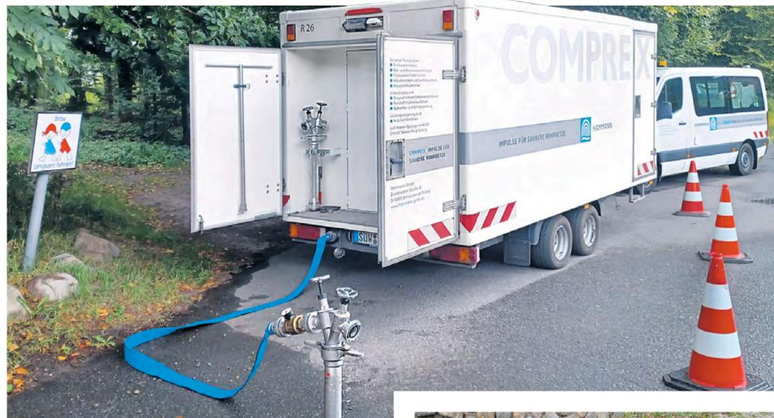
Aus dem Anhänger gab ein Kompressor Druckstöße in die Glücksburger Leitungsabschnitte ab. Durch die erhöhte Fließgeschwindigkeit steigt die Reinigungsleistung.
