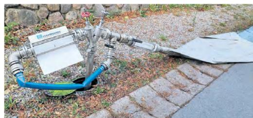
Wenn der Zylinder am Ausspeisepunkt glasklaren Durchblick erlaubt, ist die Spülung abgeschlossen.
